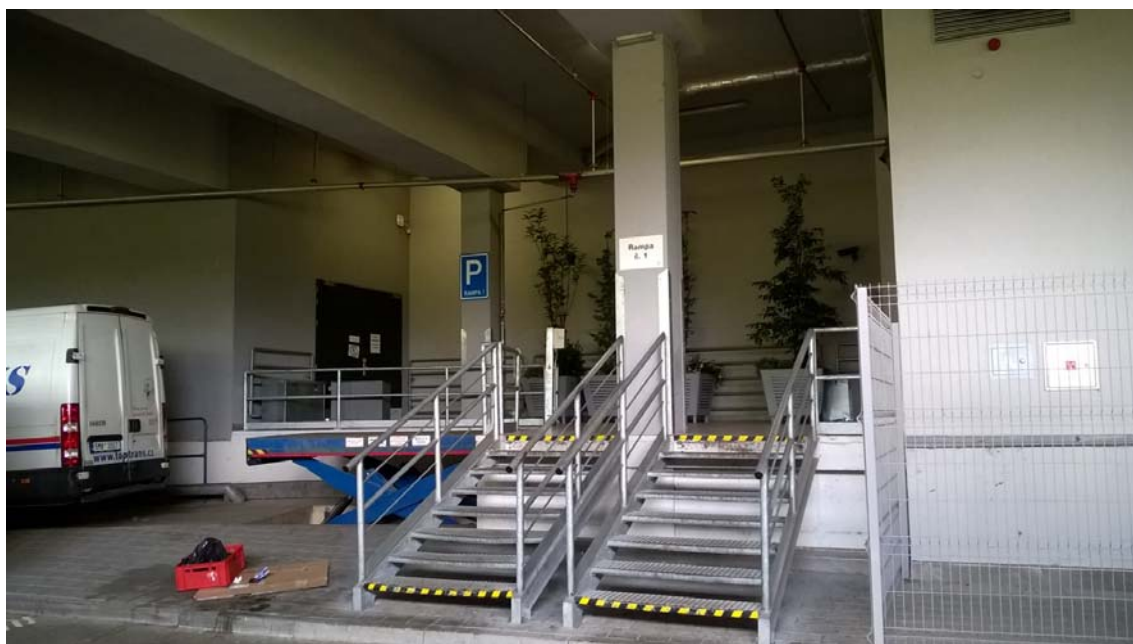
vjezd pro zásobování, rampa číslo 1
